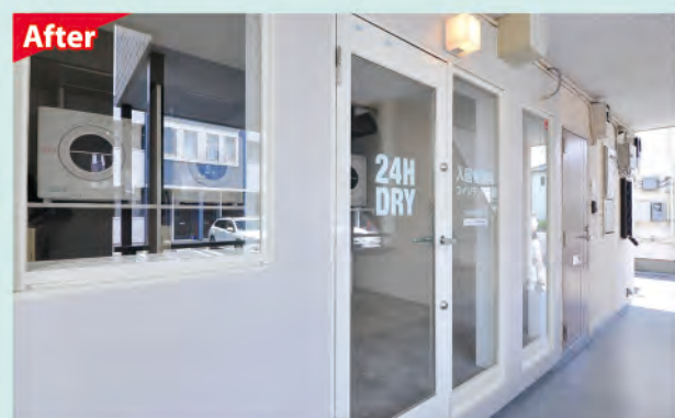
改修後／専用の出入口と、室内がよく見える開口部
