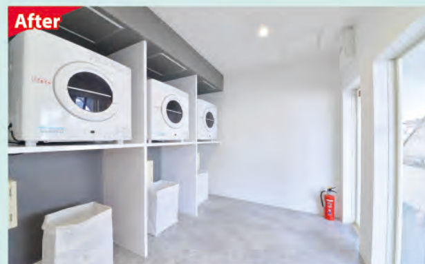
改修後／衣類乾燥機4台を設置
