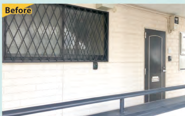
改修前／北側窓
